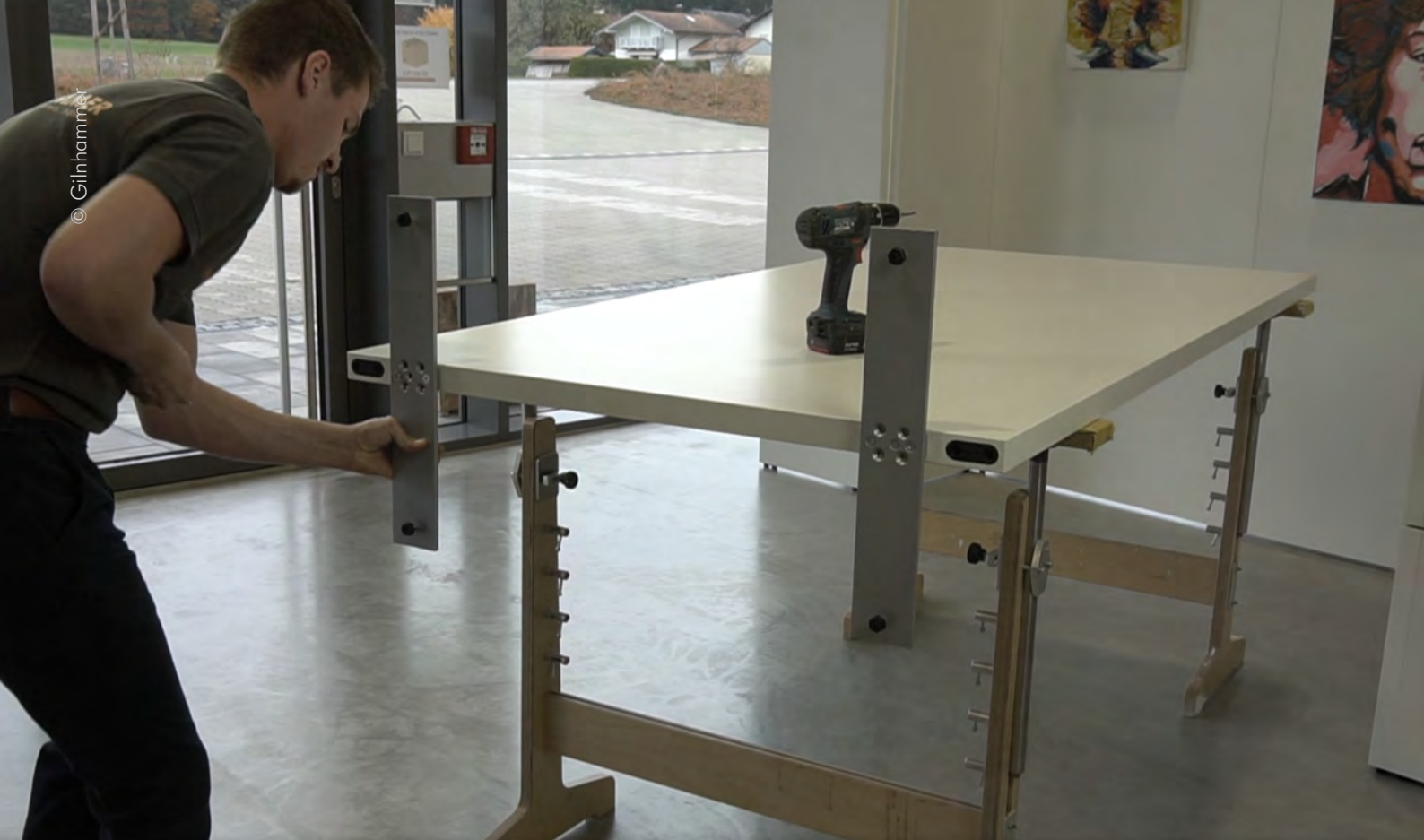
G40 QUICK unkomplizierte und schnelle Montage der Standfüsse für freistehende Wände G40 QUICK easy and quick, assembling the ground supports for freestanding wall pannels
