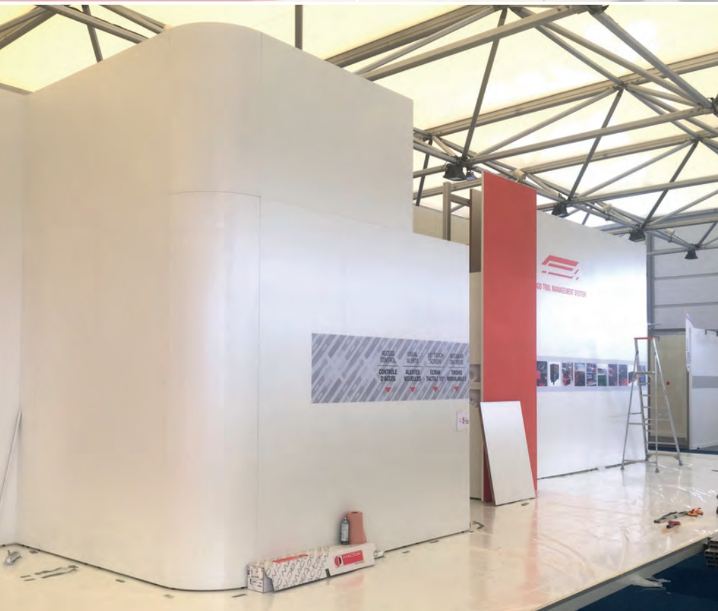
G40 CLASSIC Leichtbauwände mit Aufsatzwand, beim Aufbau G40 CLASSIC lightweight construction walls with top wall, during assembly
