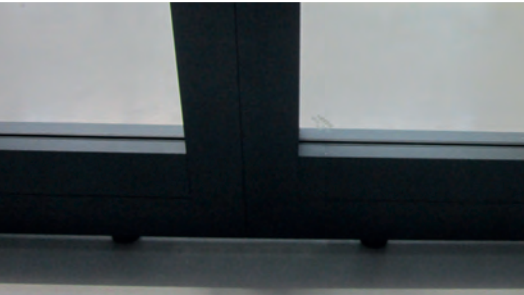
Die Eckverbindungen wurden mit den neu für das G40 CLASSIC Wandsystem entwickelten Dockverbindern verbunden. The corner connections were connected to the new Dock connectors developed for the G40 CLASSIC wall system.
