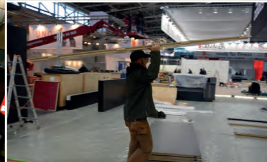
Leichte G40 CLASSIC Wandelemente beim Aufbau Lightweight G40 CLASSIC wall elements during construction
