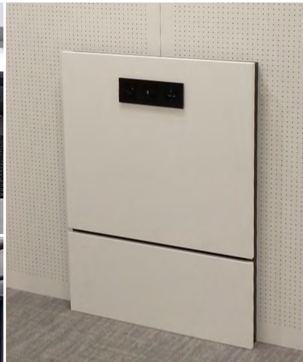
Zuluftelement mit integrierter Stromversorgung Supply air element with integrated power supply
