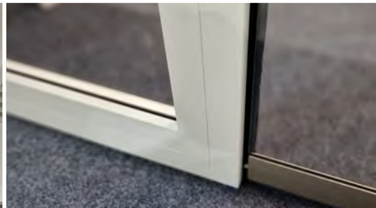
Türverbindung mit Bodenabsenkndichtung Door connection with floor lowering seal
