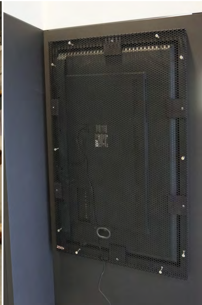
Monitor mit Schutzgitter gesichert Monitor secured with protective grille
